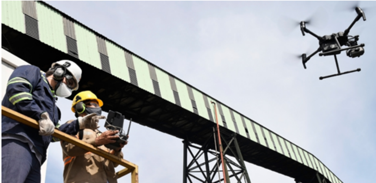
Inspección en altura. Durante 2019, el sistema emitió en forma autónoma 440 tickets de mantenimiento, eliminando la inspección humana en 55 techos.
