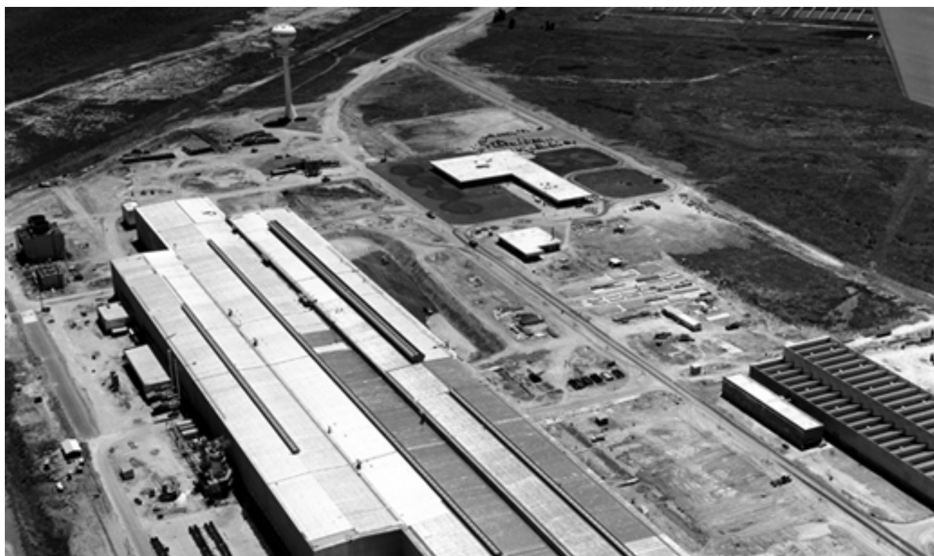
La unidad de Ensenada. Un proyecto que llevó 33 meses desde su diseño hasta la puesta en marcha de las instalaciones.
