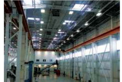
Estructura para grúas / Structure for cranes
