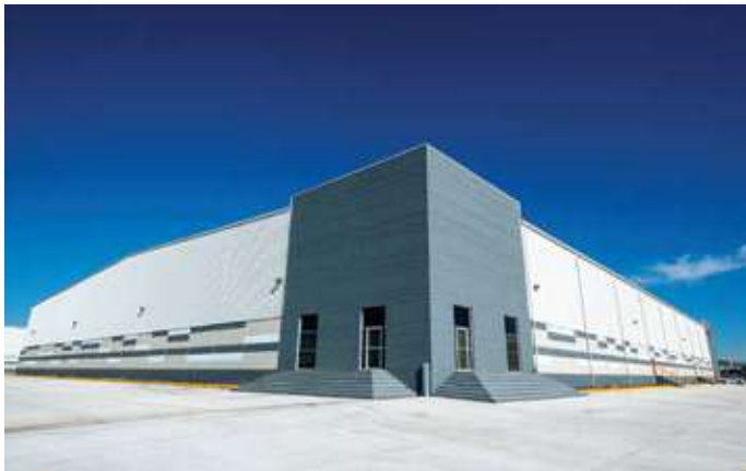
Parque industrial, Querétaro, Querétaro / Industrial Park, Querétaro, Querétaro
