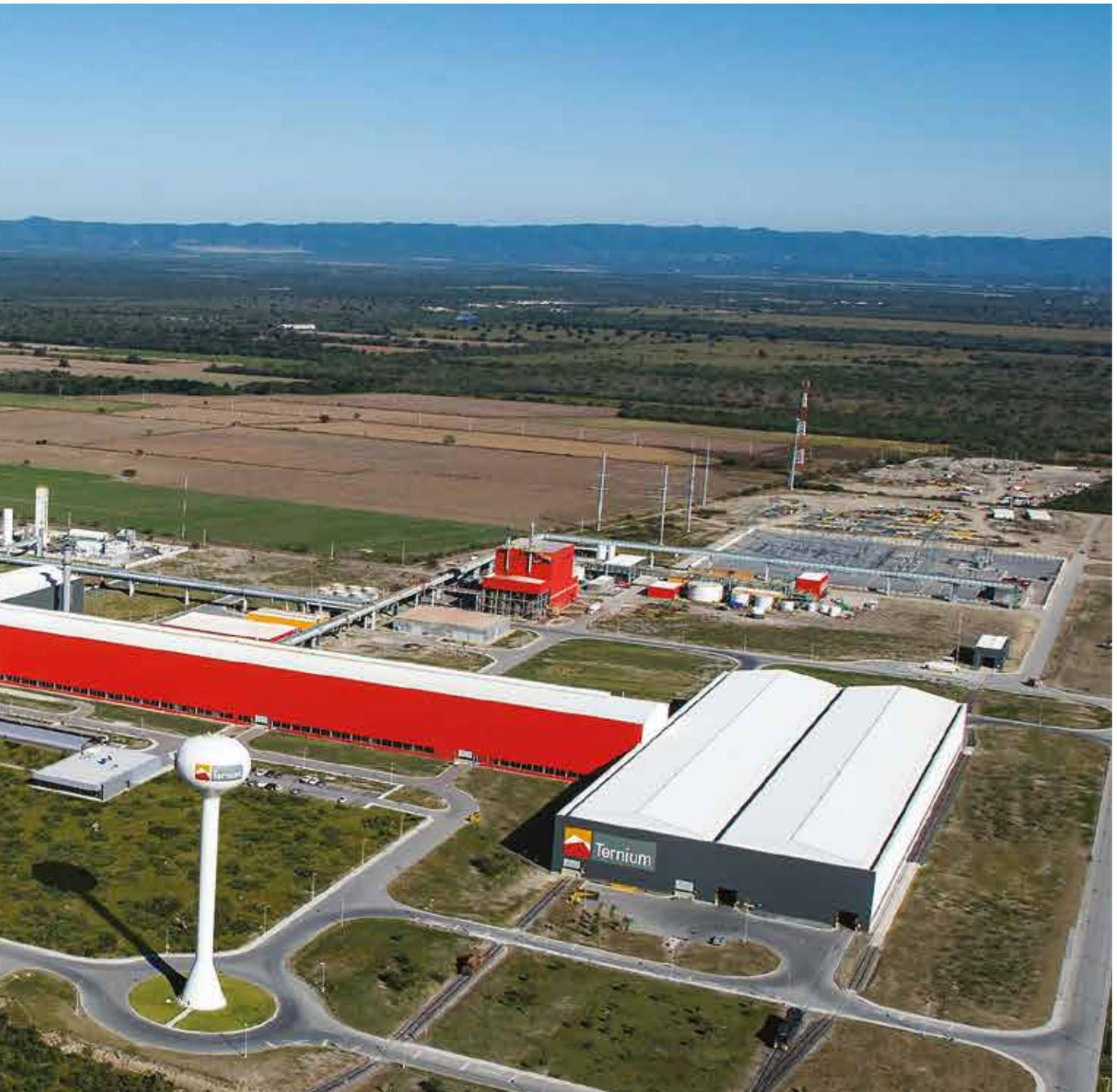
El Centro Industrial Ternium está integrado por la Línea de Decapado y Laminación en Frío en Tándem (PLTCM) y la Línea de Galvanizado Continuo, además de diversos servicios con la más moderna tecnología y eficiencia que apoyan su funcionamiento, como la Planta de Tratamiento de Aguas Cero Descargas, la Planta Regeneradora de Ácido, la Estación Eléctrica y el Laboratorio de Pruebas de Calidad, entre otros.
